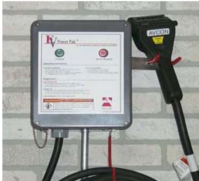
Figuur 31: Laadbox "Powerpak" voor conductieve lading, voorgesteld door Avcon Corporation (U.S.)
