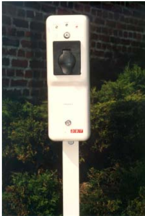
Figuur 17: Bijkomend laadpunt, te monteren op paal of op muur (Foto DBT)
