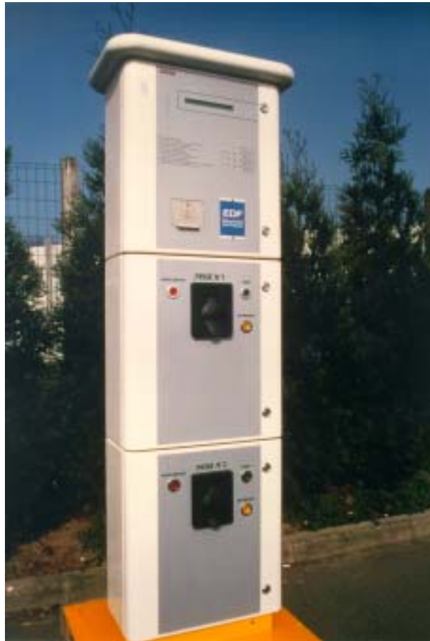
Figuur 15: Laadstation van het Franse type: basiseenheid met twee stopcontacten. Het station kan bijkomende stopcontacten bedienen. (Foto: DBT)
