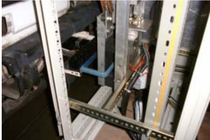
Figuur 12: Inductief laadsysteem met automatische koppeling. Merk de blauwe secundaire inductiespoel
